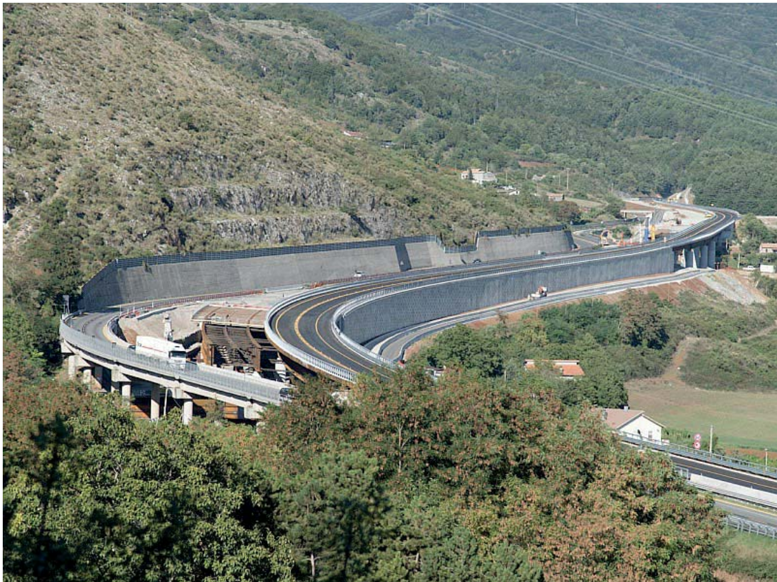
Viaduct Mancuso - L= 253 m
