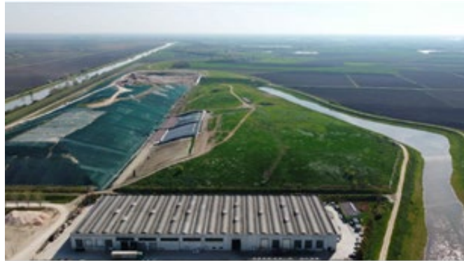
Torretta di Legnago dumpsite works, Italy
