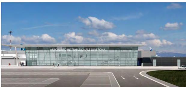
Le terminal passager est situé NE / SW parallèlement à la piste et se compose de deux volumes principaux (surface totale de 25 000 m<sup>2</sup>), séparés les uns des autres, respectivement pour les arrivées et les départs. La façade a une longueur totale de 400 mètres, alors que la largeur du bâtiment est d'environ 40 mètres seulement.
