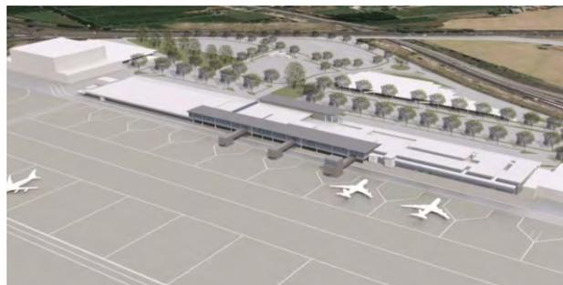
Le projet comprend l'agrandissement du terminal des départs pour environ 10,000 m<sup>2</sup> et l'amélioration de 12,300 m<sup>2</sup>. De plus, 3 nouveaux ponts de chargement et voies d'accès pour la connexion au réseau routier terrestre sont conçus.
