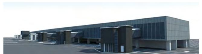
Les structures sont réalisées avec des colonnes en acier d'un espacement assez régulier (14 m - 20 m) et des poutres en treillis en raison de la grande portée. Le plancher intermédiaire et le toit sont faits d'éléments préfabriqués en béton armé. La conception comprend également une mezzanine entre le rez-de-chaussée et le toit, pour accueillir l'équipement des systèmes mécaniques.
