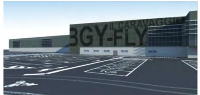
Le 1er bâtiment est de forme carrée avec 2420 m<sup>2</sup> au sol, tandis que le 2ème bâtiment est rectangulaire avec 2510 m<sup>2</sup> au sol et s'étend vers l'ouest sur une longueur de 100 m. La façade côté piste est en continuité avec la façade existante, tandis qu'une discontinuité dans la façade côté ville est introduite pour préserver le parking existant.
