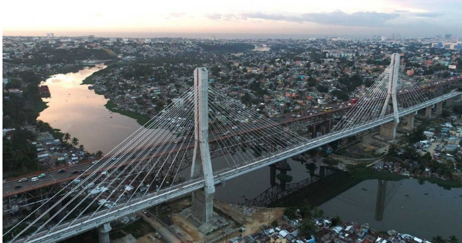
Pont à haubans sur la ligne de métro léger, Saint-Domingue
