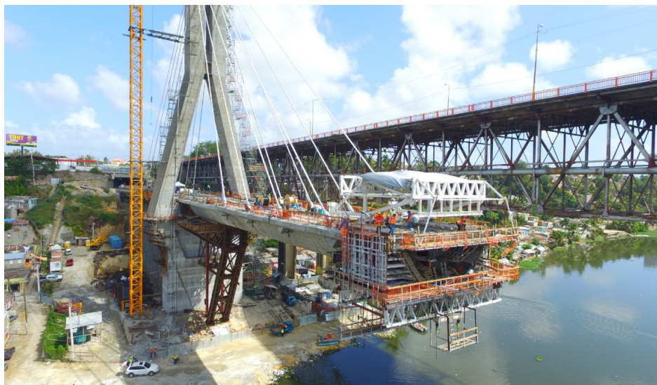
Pont à haubans sur la ligne de métro léger, Saint-Domingue
