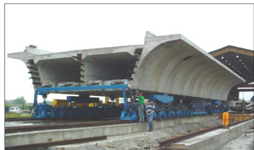
Pont en construction sur la ligne ferroviaire à haute vitesse, Plaisance - Italie
