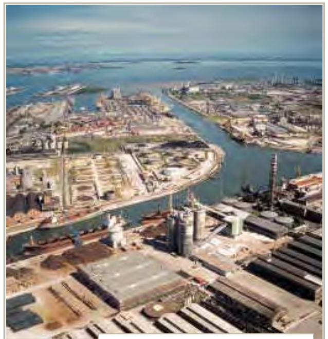
Travaux chimiques à Marghera
