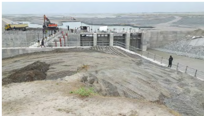
Canal pour le Barrage Yetim Tapa
