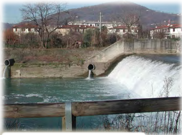
Travaux de protection des rives en aval du pont
