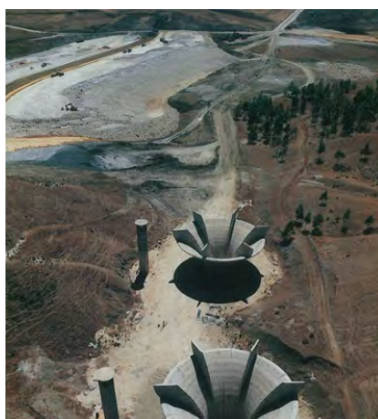
Évacuateur de crues
