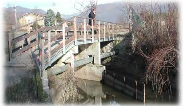
Travaux de prise sur la rivière Grande
