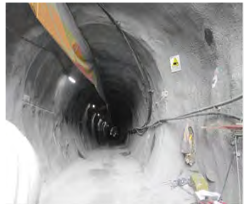
Tunnel de la décharge inférieure
