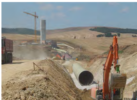
Étape de construction
