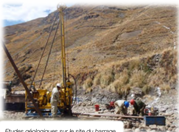
Etudes géologiques sur le site du barrage
