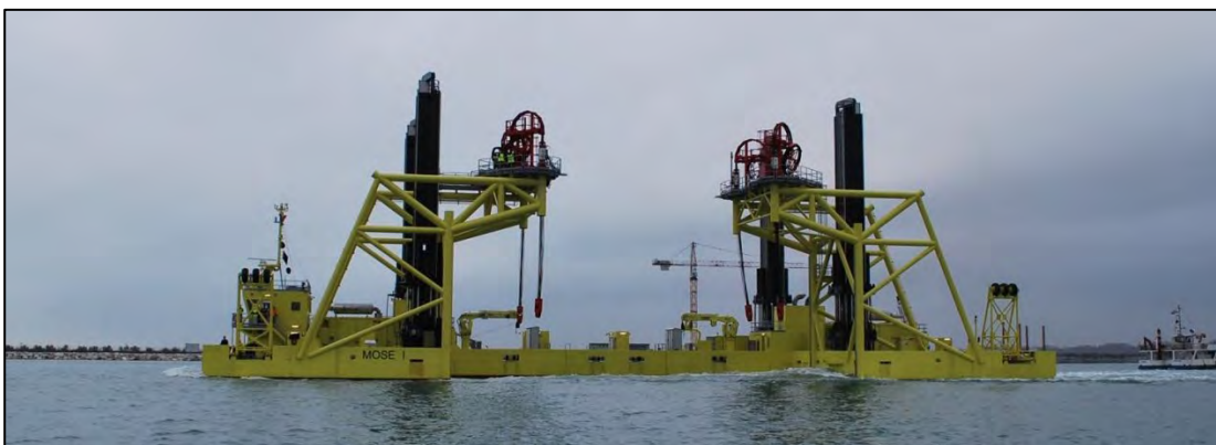
Plateforme autoélevatrice – Vue
