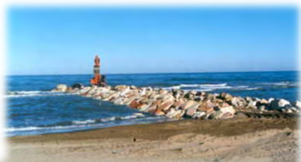
Travaux de construction d'un nouvel épi de protection de la plage
