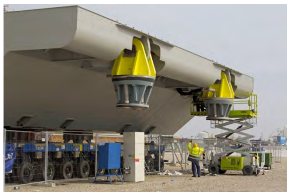
Barrages de retenue mobiles métalliques
