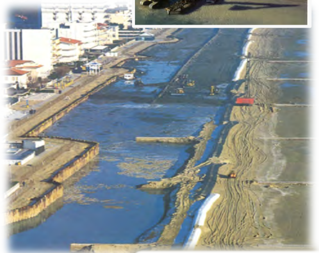
La plage de Jesolo pendant les travaux
