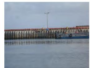
Le pavage derrière les quais est constitué d'une couche de pierres compactée avec un revêtement d'asphalte. Les quais sont conçus pour supporter la charge engendrée par la grue, les actions causées par la houle et le mouillage des navires et prend en considération la sismicité de la zone (3 = risque sismique moyen-élevé).
