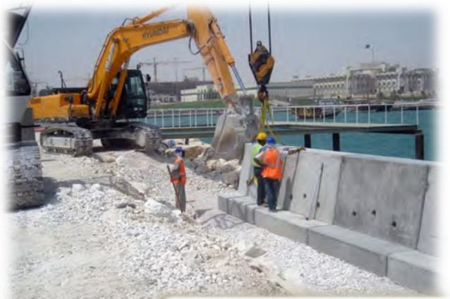
Mole: pose du béton crête en block du mur
