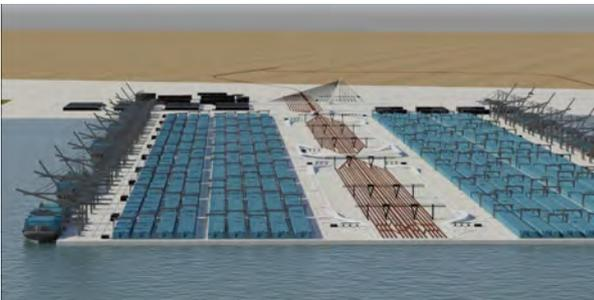
Le projet comprend 2.000.000 m<sup>2</sup> de cour pour l'empilement des conteneurs du terminal, 600.000 m<sup>2</sup> de cour pour le vrac sec et 1.000.000 m<sup>2</sup> de cour terrestre pour les bâtiments et entrepôts 200.000 m<sup>3</sup> de silos pour le blé.
