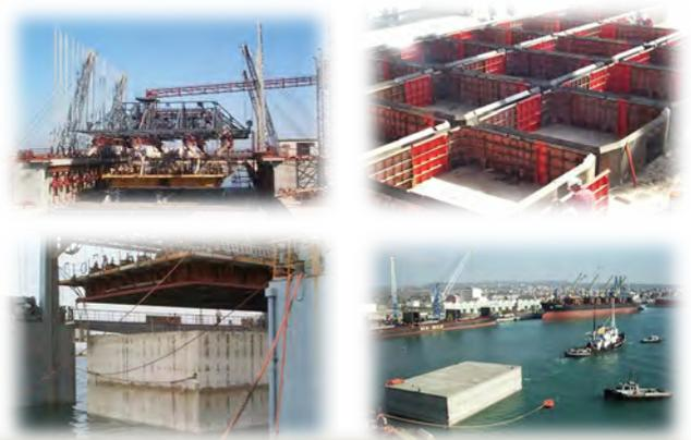
Phases typiques de construction, assemblage et transport d'un caisson en béton armé préfabriqué
