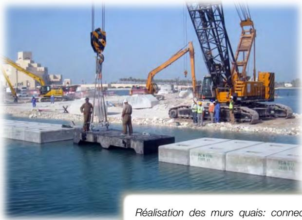
Réalisation des murs quais: connectant le box en béton souterrains.
