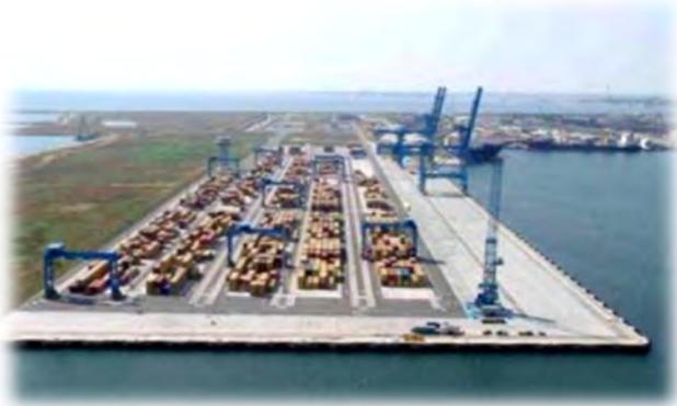
Le pavage, construit uniquement sur une partie de la zone asséchée (figure cidessus), était en différentes couches et matériaux suivant l'utilisation prévue. Au cours du fonctionnement du terminal, le terminal à conteneurs de Constanta Sud a subi un fort tassement de la structure du pavage soutenant les conteneurs dans le dépôt de stockage. Cette étude avait donc pour but d'analyser ces tassements, en vue d'expliquer les causes et le risque possible d'affaissement futur.
