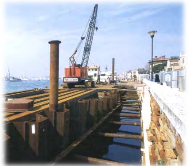
Les murs du quai comprennent aussi des ponceaux de service pour loger des égouts de un mètre de diamètre, des clapets d'interconnexion et des câbles électriques.
