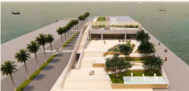
L'ensemble du terminal est distribué sur un bâtiment rectangulaire de 33 m de large et 68 m de long, qui s'étend avec les terrasses extérieures jusqu'à une longueur de 106 m. La structure est réalisée en béton armé et elle est fondée sur des pieux.
