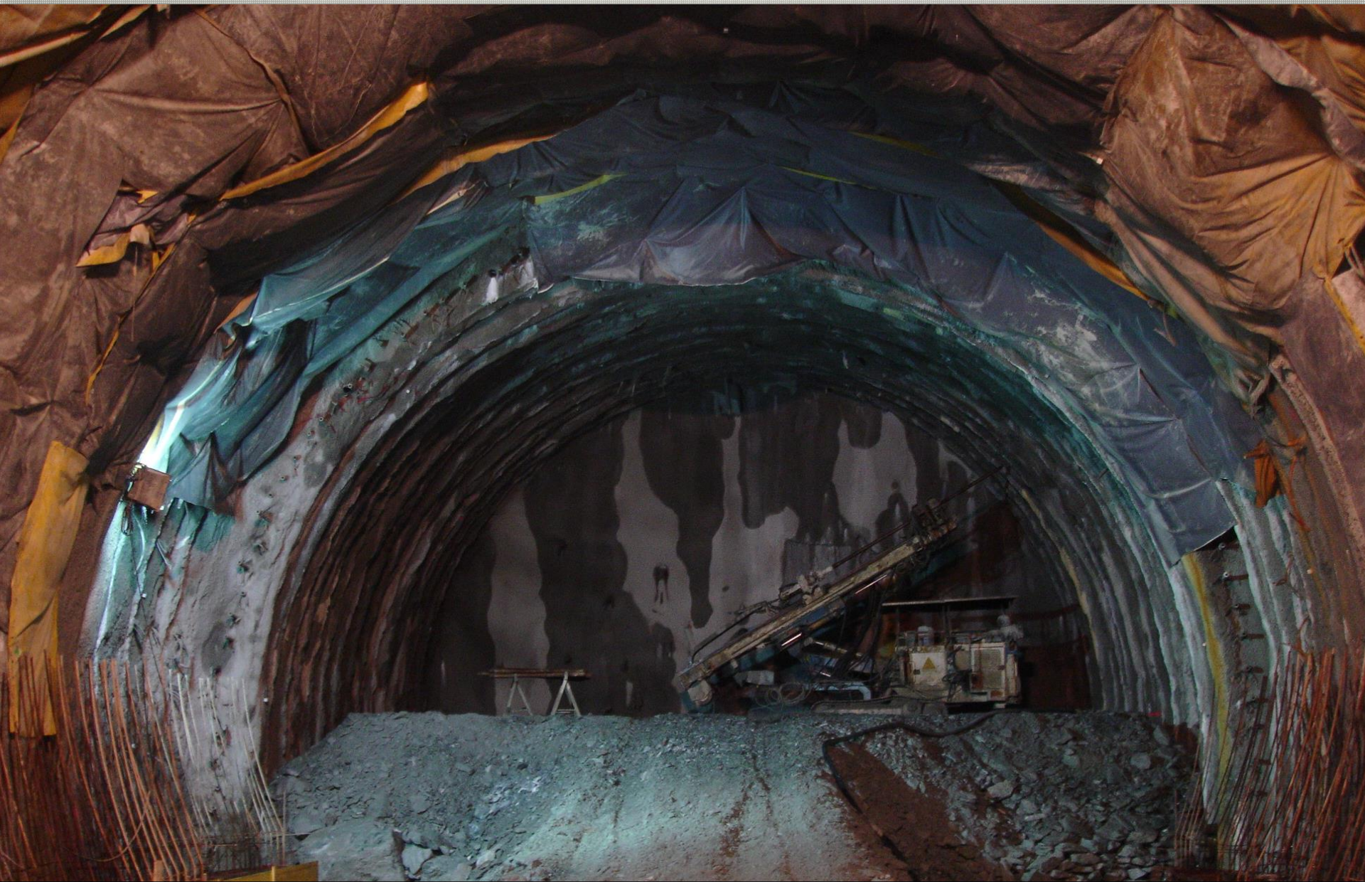
TRAVAUX DE REHABILITATION DE LA ROUTE ENTRE ETROUBLES ET LA JONCTION AUTOROUTIERE DU TUNNEL DU SAN BERNARDO | Italie
