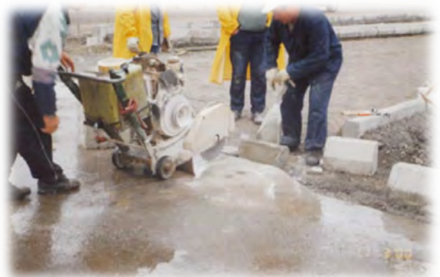
Réparation des dommages d'érosion sur le passage supérieur du chemin de fer
