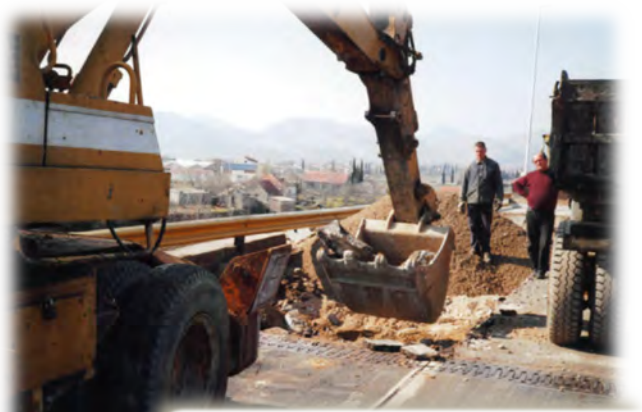
Réparation des dommages d'érosion sur le passage supérieur du chemin de fer
