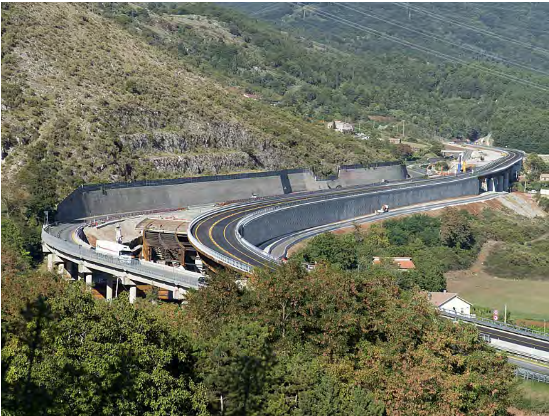
Viaduct Mancuso - L= 253 m
