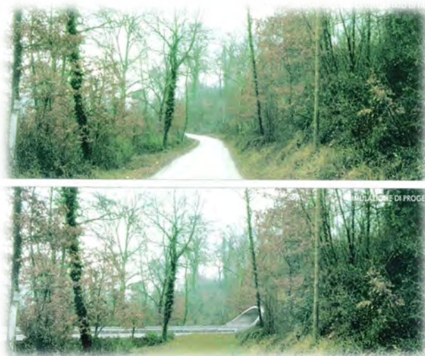
Entrée du tunnel avant et après les travaux
