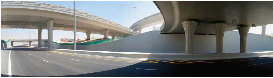
Échangeur industriel, Doha - Qatar
