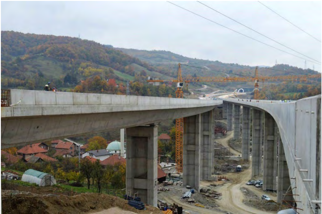
Viaducs à deux chaussées - Bosnie-Herzégovine
