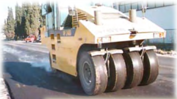
Compactage de la couche d'usure de la route M2
