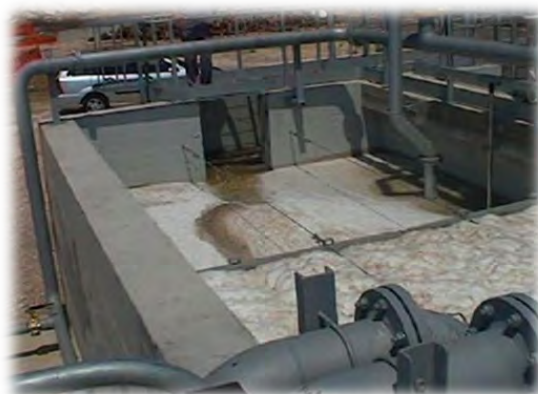
Les ouvrages pour un premier lot fonctionnel sont achevés.
