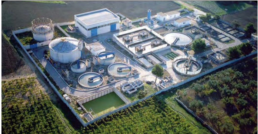
Mottola (Taranto) usine de d'épuration
