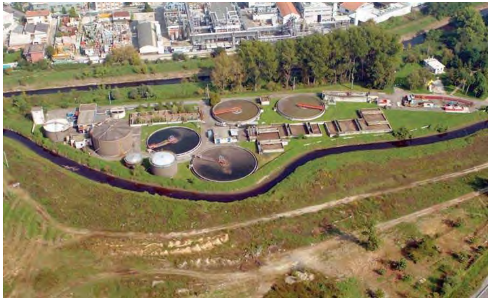
Usine de traitement des eaux usées de Rozzano
