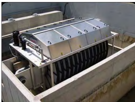
Usine de d'épuration de Castelfranco Veneto (Padoue): usine de filtration et de désinfection
