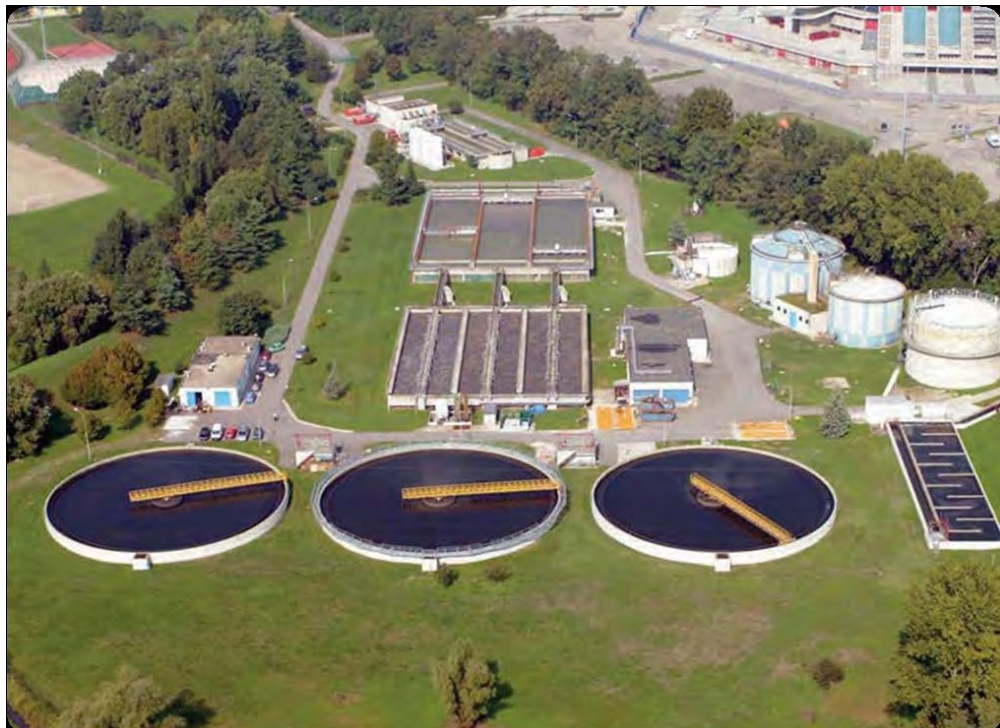
Usine de traitement des eaux usées de Cesano Boscone, Corsico, Buccinasco et Assago (Milan)
