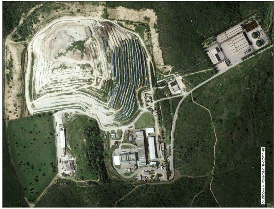
Station de traitement des déchets Spiritu Santu, Italie
