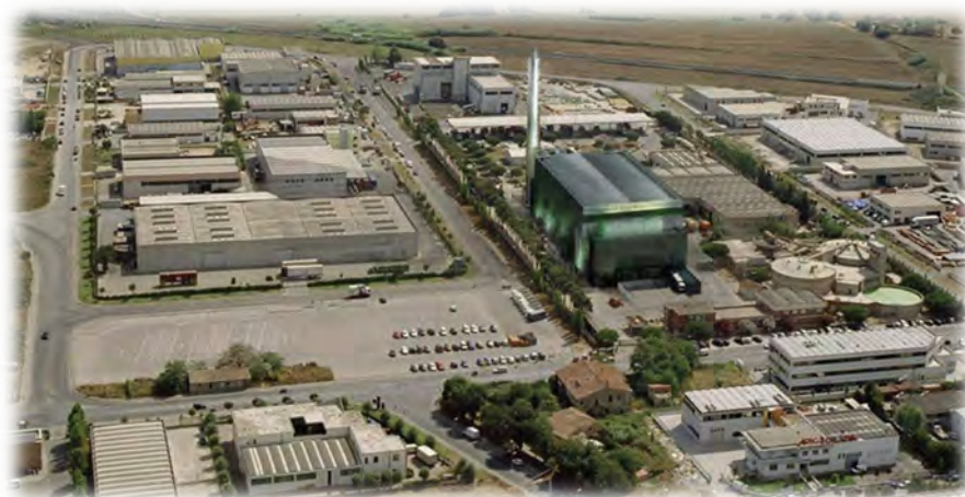
Usine de valorisation énergétique des déchets à Livourne
