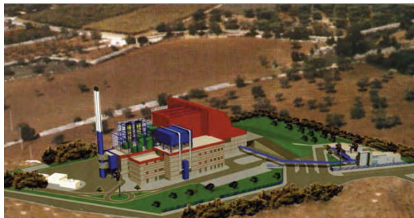
Usine de valorisation énergétique des déchets de Lecce
