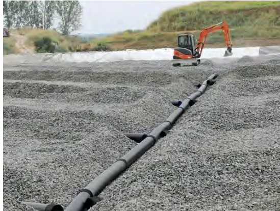
Travaux de décharge de Torretta di Legnago, Italie
