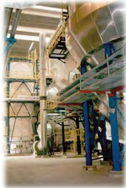
Usine de valorisation énergétique des déchets de Busto Arsizio
